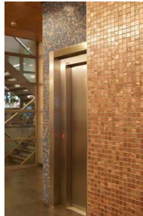
De dragende wanden en de liftwanden zijn opnieuw bekleed met glasmozaïk
